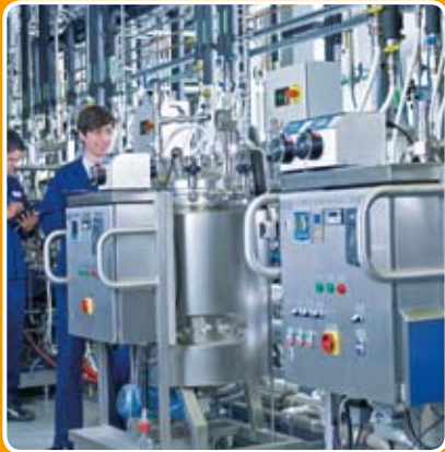
Bild links: Technikum der Süd-Chemie AG, welche eine Demonstrationsanlage zur Herstellung von Bioethanol der 2. Generation in Straubing-Sand errichtet
